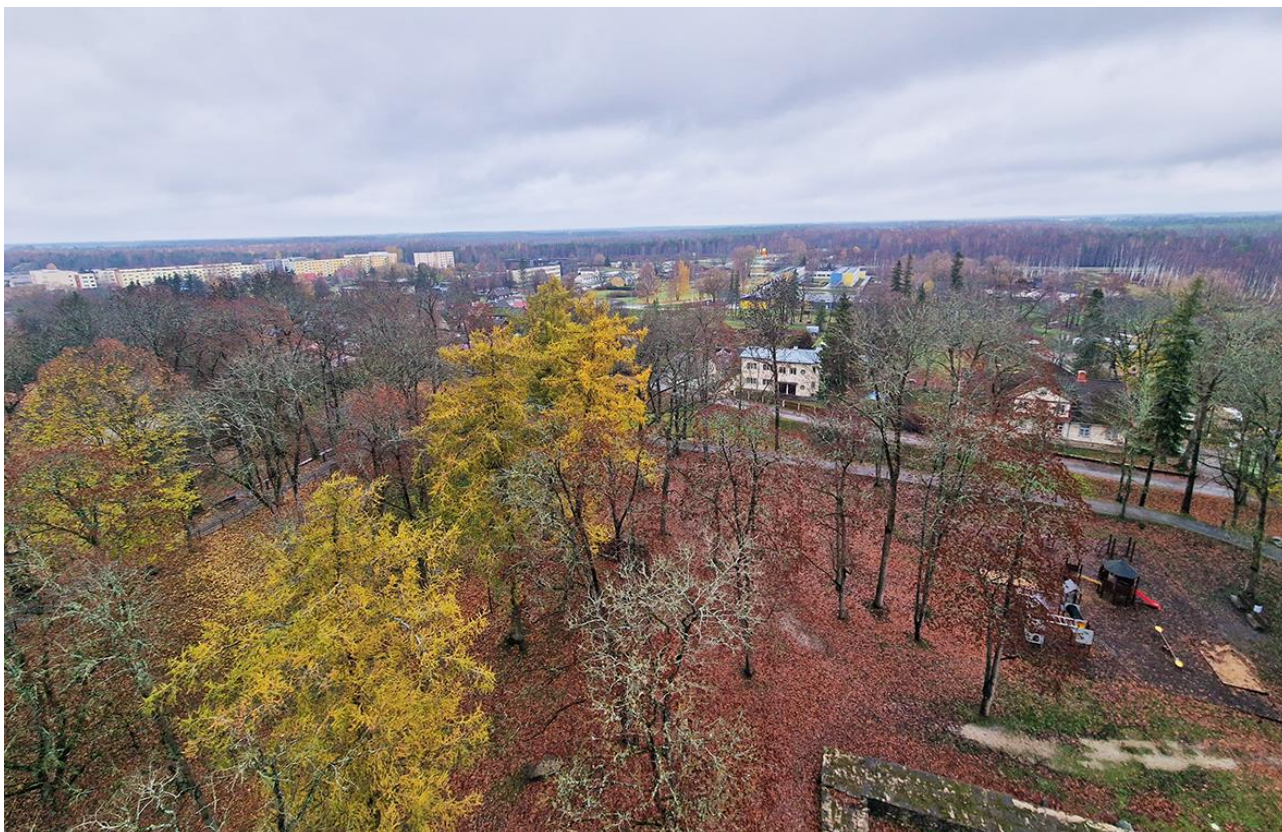
Foto 11. Vaade vallitornist põhja suunale.
