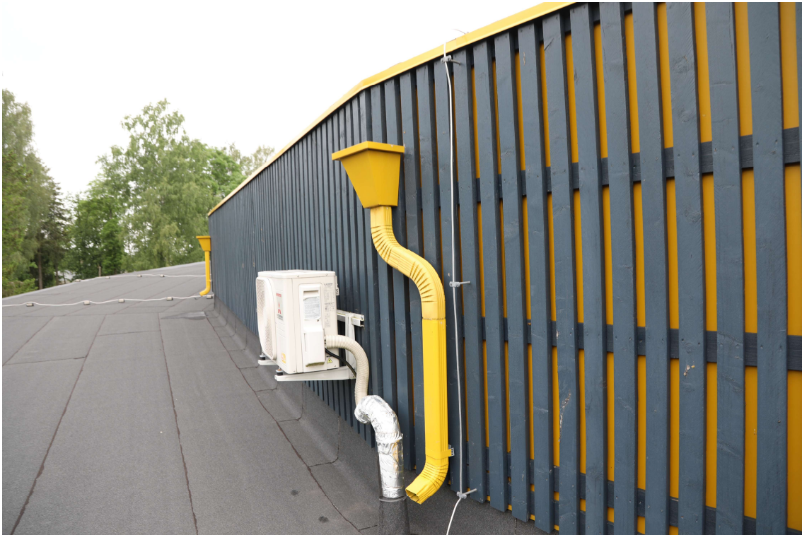
Foto 5. Hoonekarbi tuulduva seina- ja lamekatusetarindi liide.
