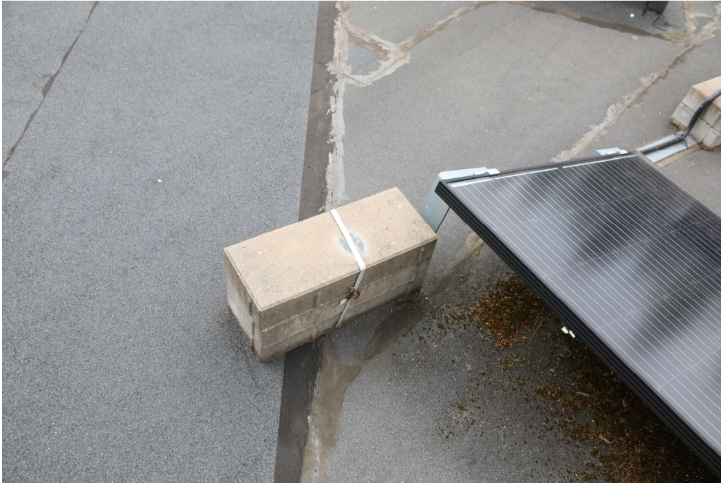
Foto 13. Katusetarindi hüdroisolatsioonikihti on kohati parandatud MBR kihi pealekeevitamise ja ülekatetele mastiksi pealemäärimisega.
