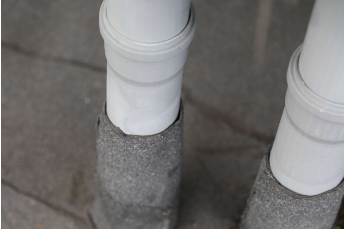
Foto 27. Torudele tehtud MBR kihi ülestõstete ülaserv ei ole veertihe.
