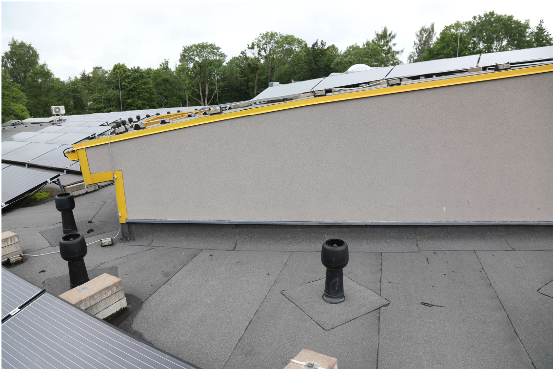
Foto 19. Katusetarindile on paigaldatud difusiooniõhutid. PIR soojusisolatsiooniga katusetarindil on difusiooniõhutid mõttetud ja need tuleb eemaldada.
