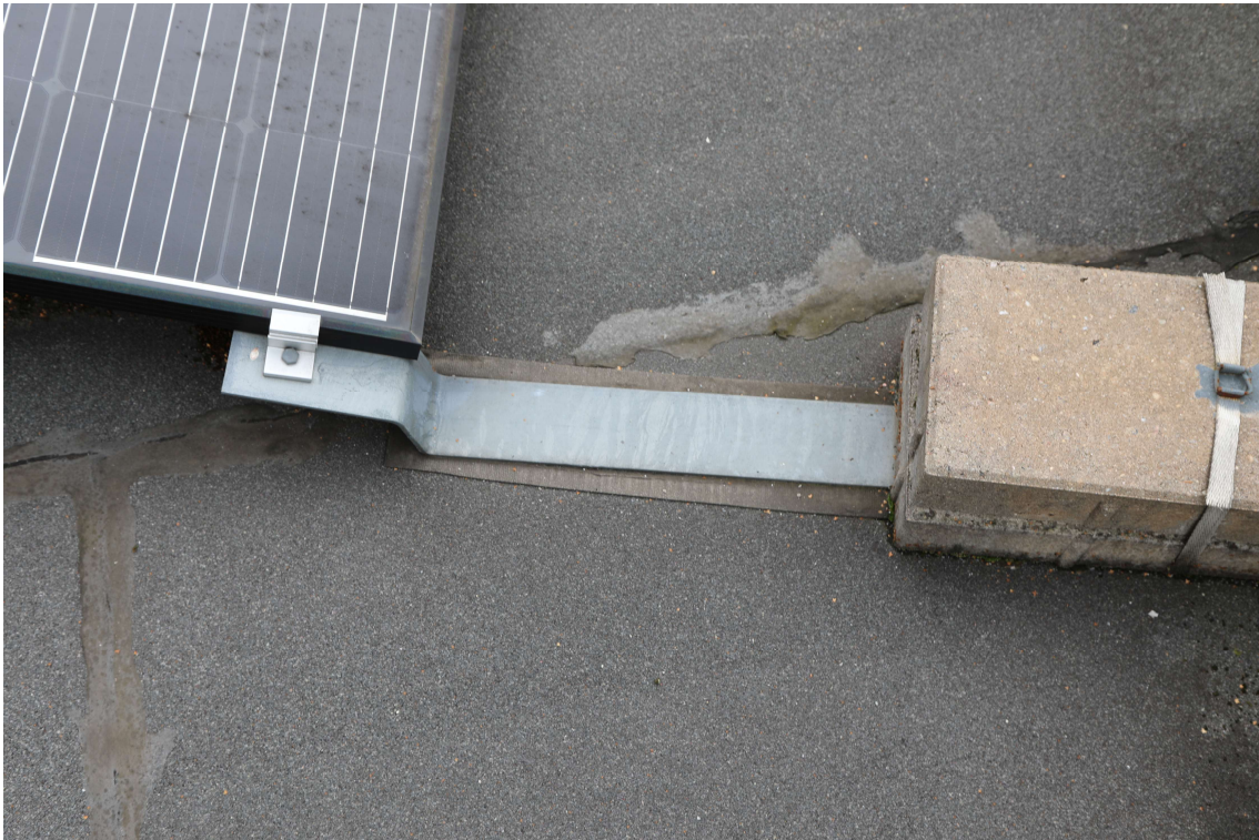
Foto 15. Kiviballasti sellina paigaldus kahjustab pikas perspektiivis katusetarindi hüdroisolatsioonikihti ja soojusisolatsioonikihti. Plastlindid ballastikivide koos hoidmiseks ei ole pikaajaline lahendus.
