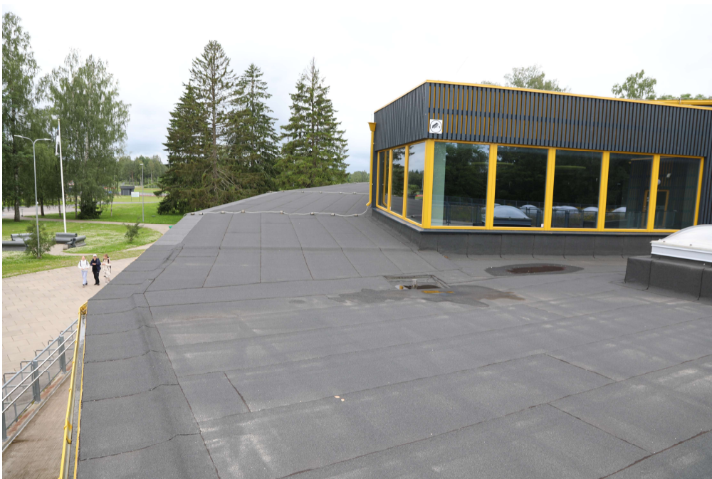
Foto 2. Hoonekarbi lamekatusetarind on ehitatud spiraalse kujuga tõusvas joones.
