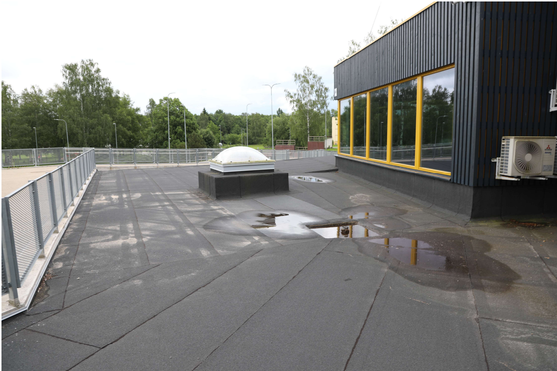
Foto 3. Vaade sisemise äravoolusüsteemiga katusetarindi osale.
