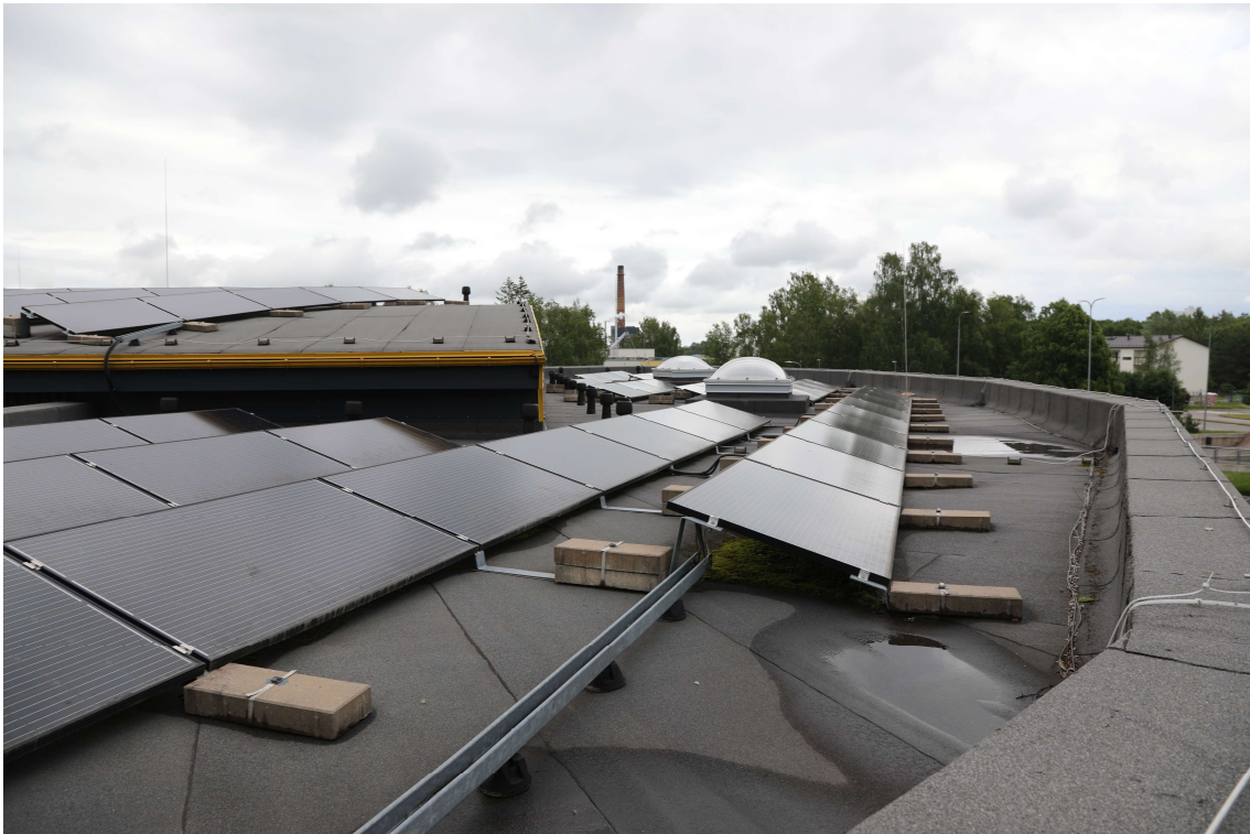
Foto 7. Vaade keskmise tasandi sisemise äravoolusüsteemiga katusetarindi osale. Sademevee äravool on lahendatud parapetti läbivate veesülititega. Katusetarindile on paigaldatud päikesepaneelid (edaspidi PV).
