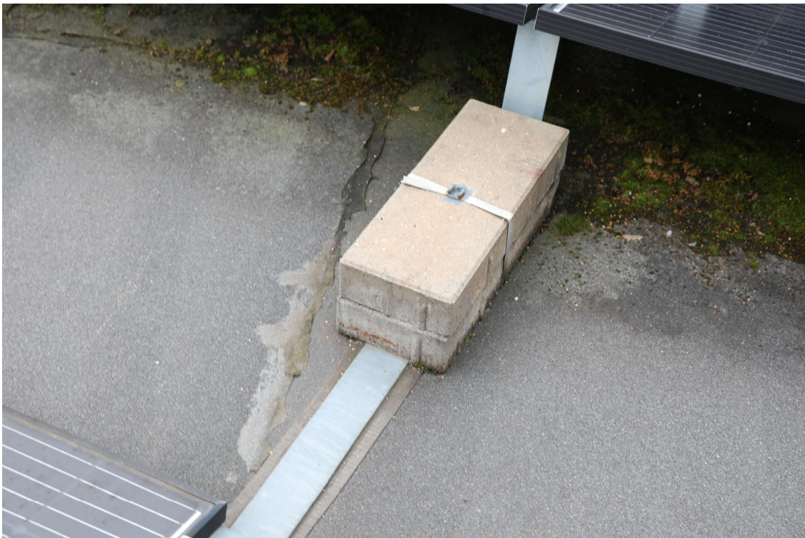
Foto14. Lattraua alla paigaldatud täiendav MBR kiht ei kaitse katuse isolatsioonitarindit piisavalt. Samuti kipub MBR kiht alusel libisema.
