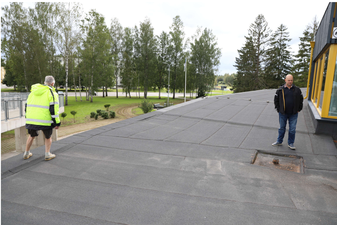
Foto 6. Vaade sisemise äravoolusüsteemiga lamekatusetarindi osale.
