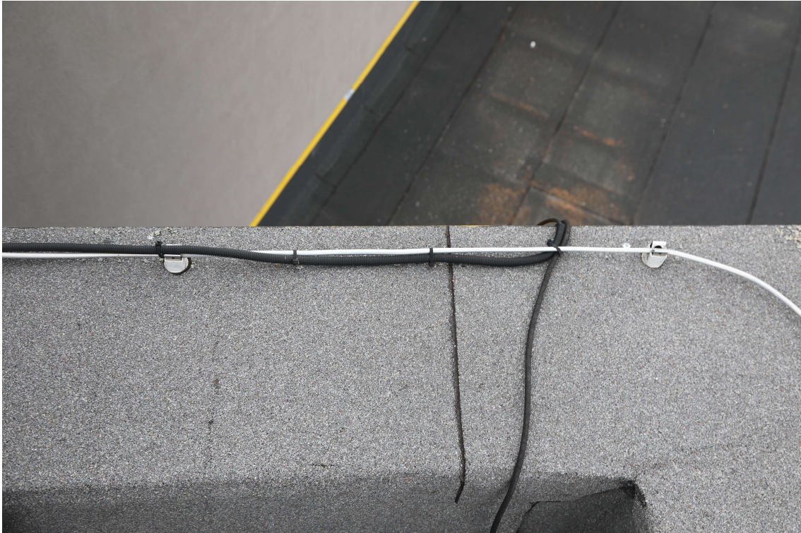
Foto 25. Piksekaitse kinnitite paigaldamine läbi MBR kihi ei ole pikaajaliselt veetihe lahendus.
