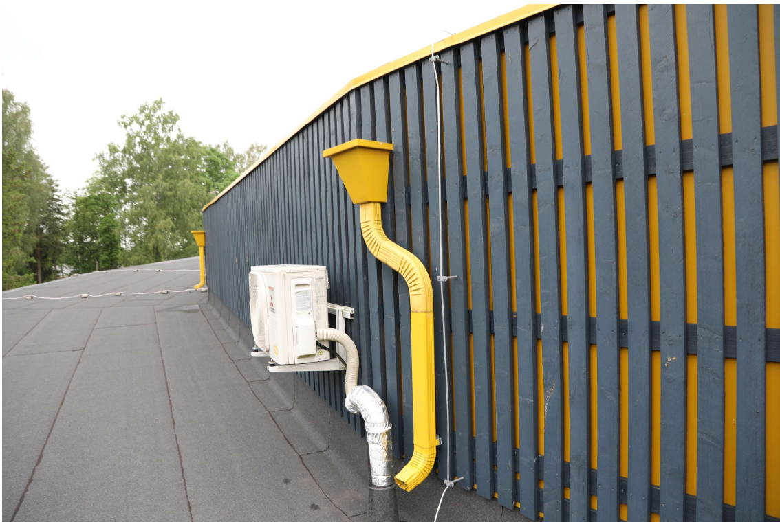
Foto 24. Seinatarindile on paigaldatud veesülitite alla veekogujad ja allaviigitorud. Jahutusagregaadi kaablite ja torude läbiviik ei ole pikaajaliselt veetihe.
