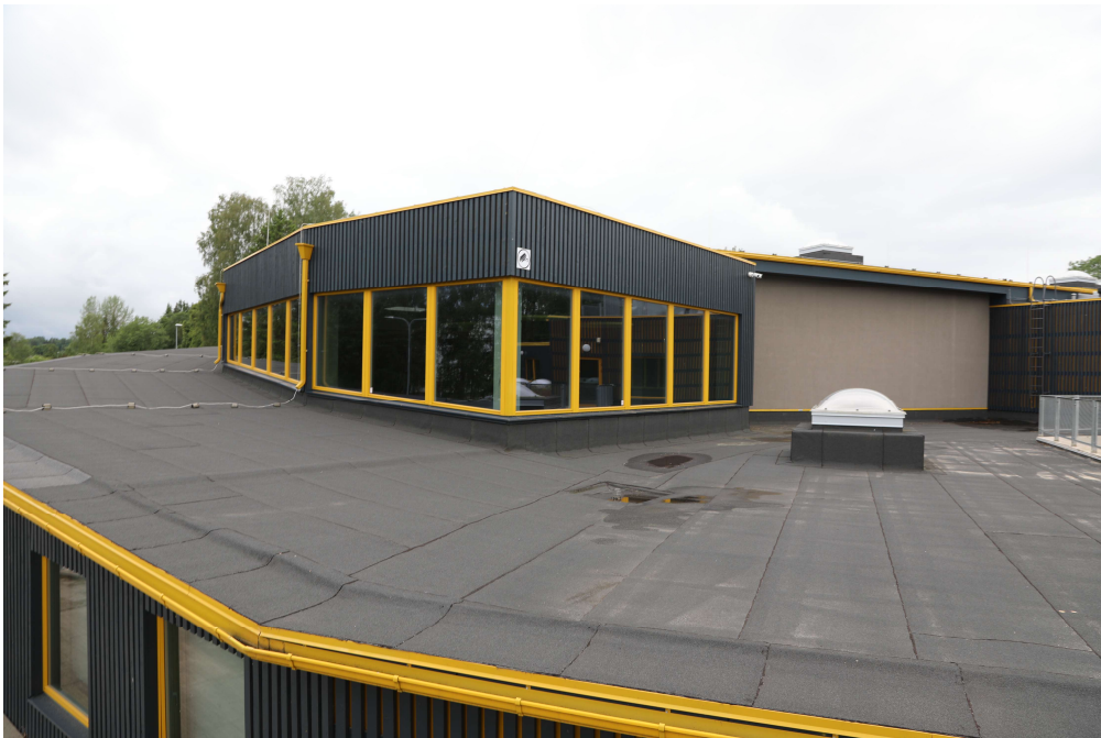
Foto 1. Vaade hoonekarbi katusetarindi osale. Hoonekarbi katusetarindid on nii sisemise kui välimise äravoolusüsteemiga. Fotol on näha I etapis töösse mineva välisseinatariindi nurk. Remonditav osa on sinise puitlaudisega kuni krohvitud välisseinatrindini.
