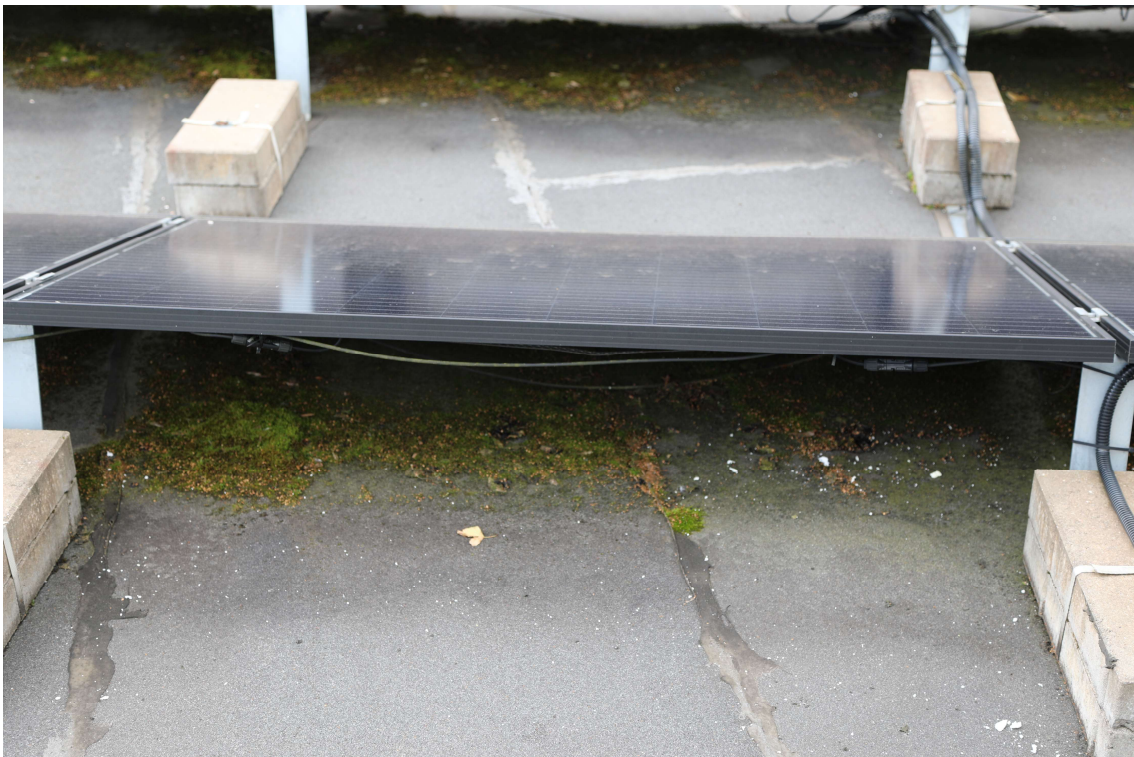
Foto 18. Sama lähivaates. Eemaldamata sammal kahjustab pikas perspektiivis katusetarindi hüdroisolatsioonikihti.
