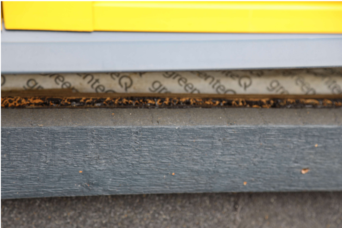
Foto 7. Aknaaluse sokliosa ja akna liited ei ole veetihedad. Tugevamate tuultega altpoolt ülespoole liikuv või pritsiv sademevesi pääseb liidetest sisse.
