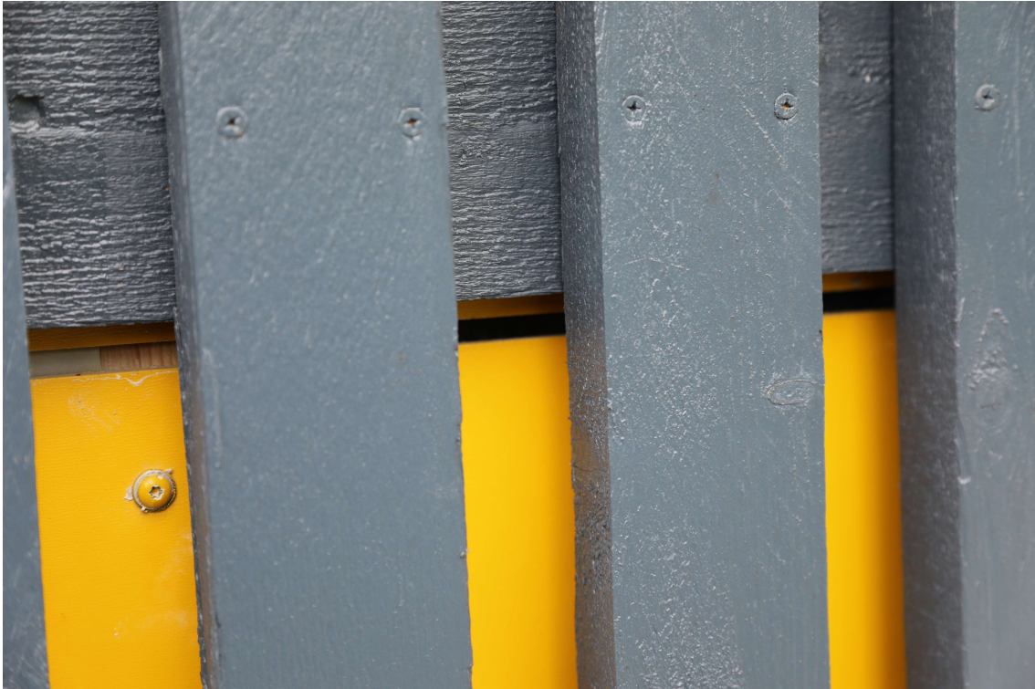
Foto 14. Seinatarindi katteplaatide liitekohtadest pääseb sademevesi kaldvihmaga hõlpsasti seinatarindisse.
