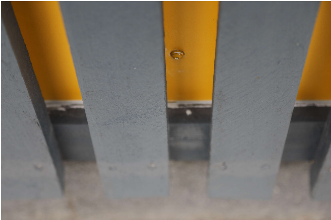
Foto 13. Seina- ja katusetarindi liide ei ole veetihe. Pealemääritud mastiks ei paranda olukorda.
