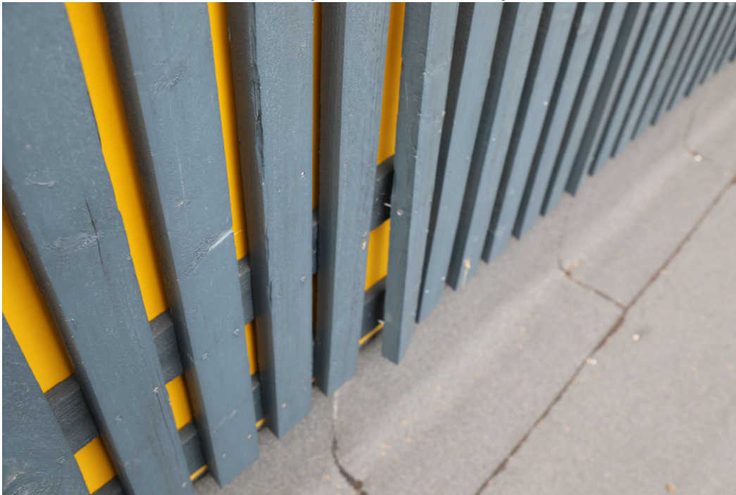
Foto 9. Mõnes kohases on dekooriks paigaldatud laudis vääändunud.
