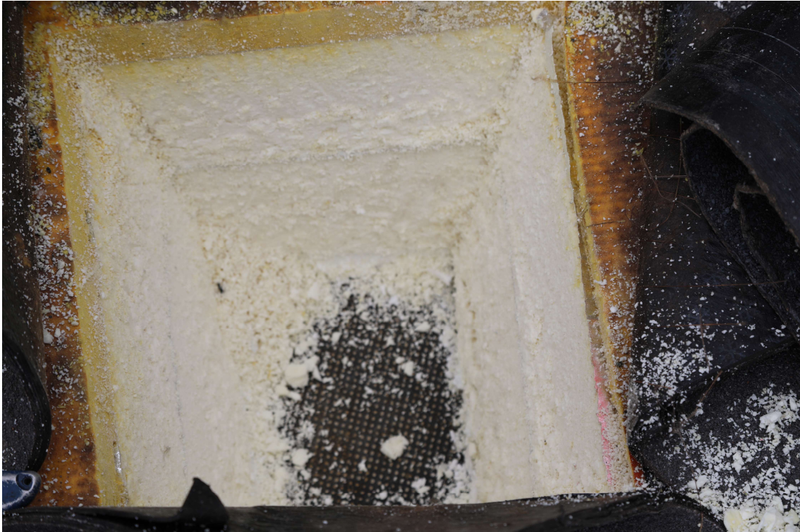
Foto 5. Katusetarindi soojusisolatsiooni ja kaldekihi all on MBR aurutõkkekiht.
