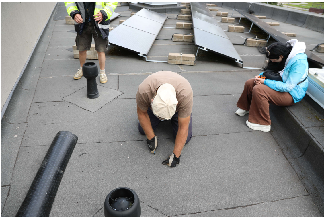
Foto 2. Keskmise katusetarindi osa avamine 21.08.2025.
