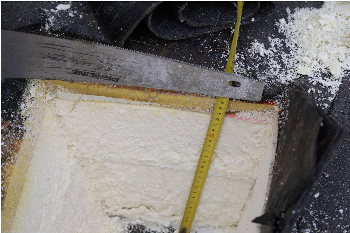
Foto 6. Avatud kohas on katuse isolatsioonitarindi soojusisolatsiooni ja kaldekihi kogupaksus 260 mm. PIR soojusisolatsioonikihi paksus on 200 mm. Katuse isolatsioonikihid ja aurutõkkekihi pind olid kuivad.
