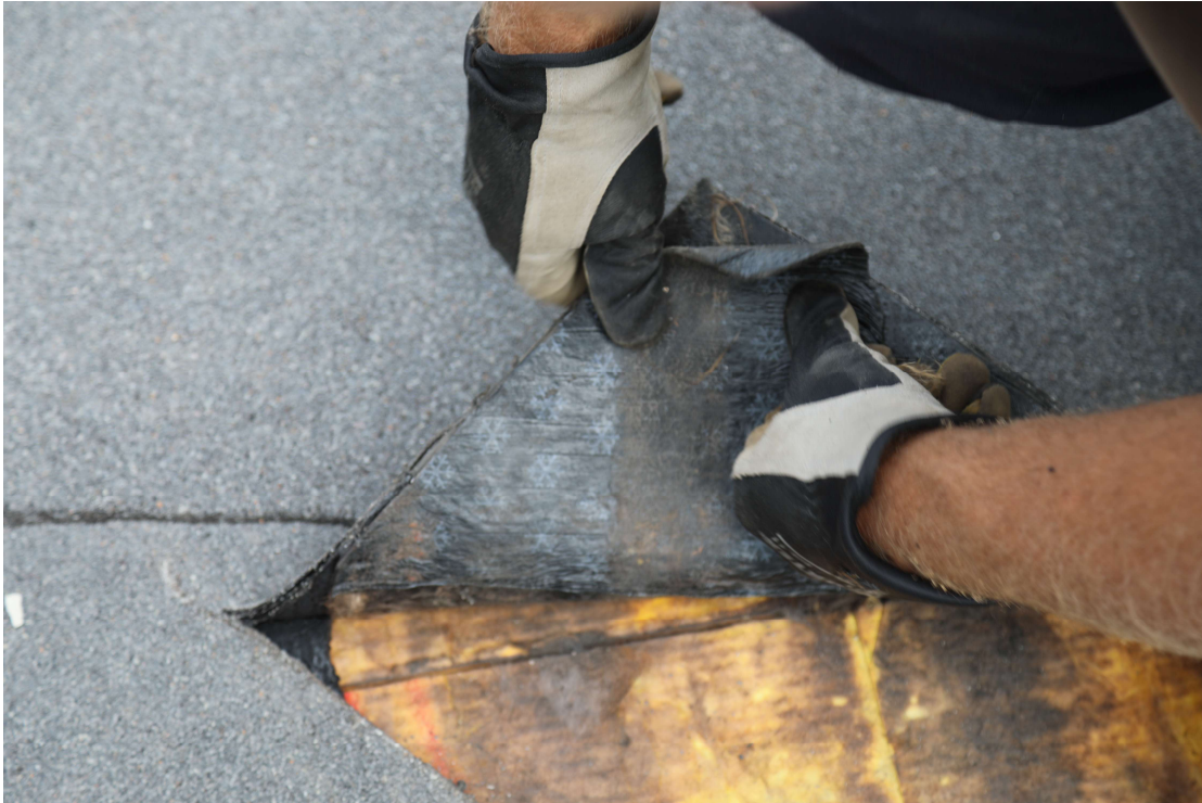
Foto 3. Tavapärase katuse isolatsioonitarindit katab kahekihiline MBR. Kohati on katusetarindit remonditud ja paigaldatud kolmas MBR kiht. MBR kihi all on 30 mm MW kiht.
