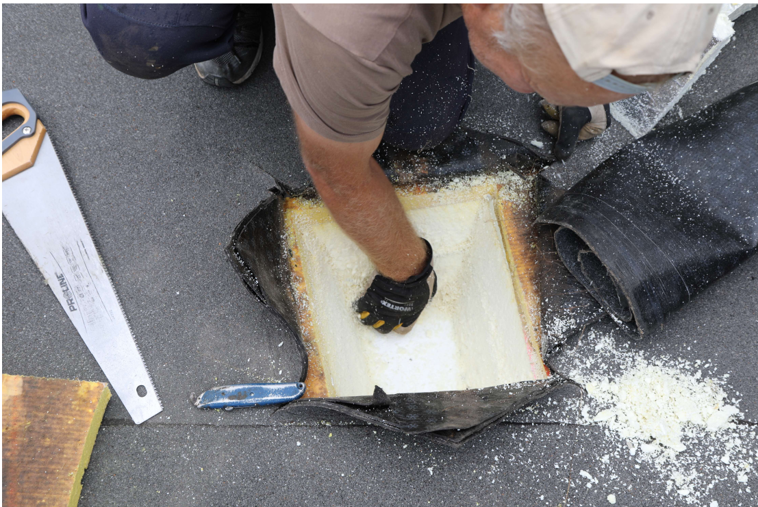
Foto 4. MBR kihi all on 30 mm MW kiht. Katuse soojusisolatsioonikiht on Al fooliumiga kaetud PIR plaatidest. PIR kihi all on kaldu lõigatud EPS kiht katusetarindile kalde moodustamiseks.
