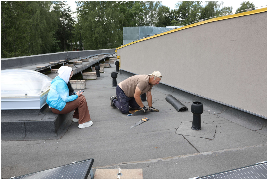
Foto 1. Keskmise katusetarindi osa avamine 21.08.2025.
