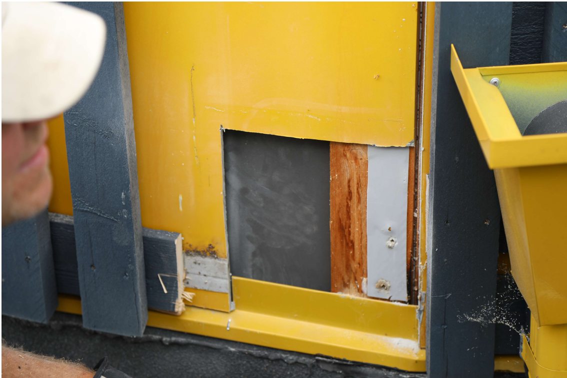
Foto 5. Fassaadikatteplaadi all on ca 30 mm laiune tuulutusevahe, mis on loodud puitroovidega.
