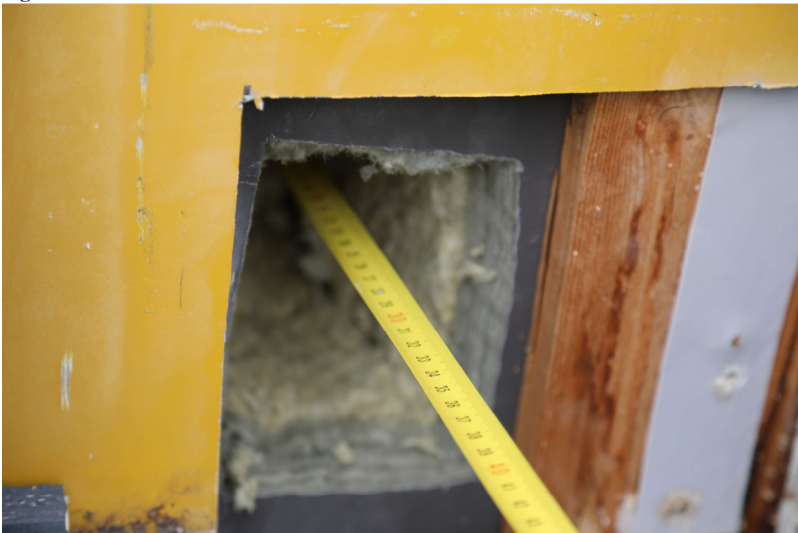
Foto 10. Seinatarindi MW soojusisolatsioonikihi paksus on ca 300 mm.
