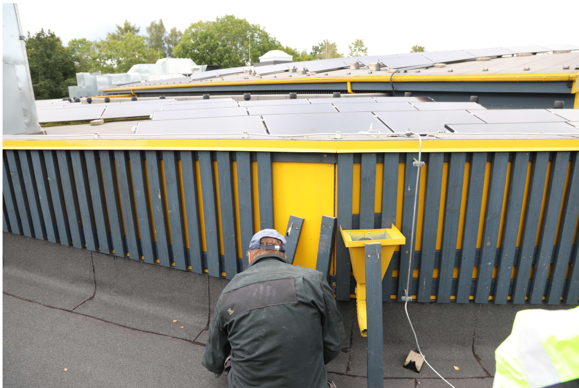
Foto 1. Tuulduva fassaadi avamine.
