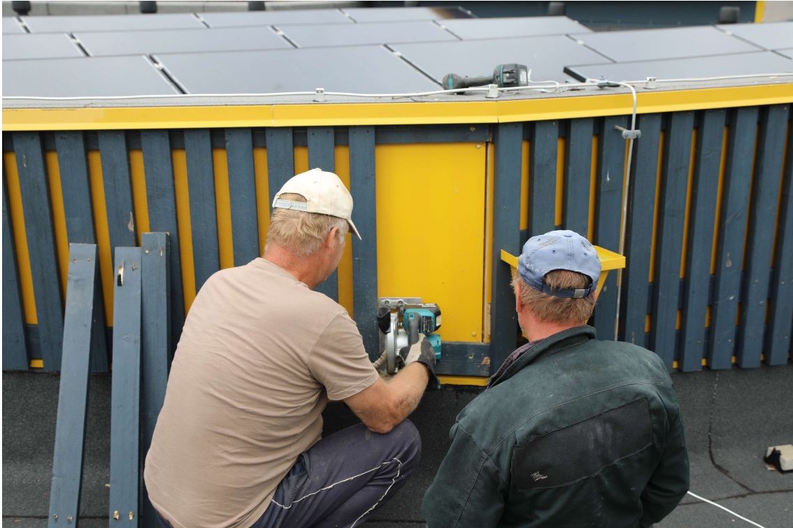
Foto 3. Seinatarindi katteplaatide avamiseks tuleb eemaldada puitdekoor.
