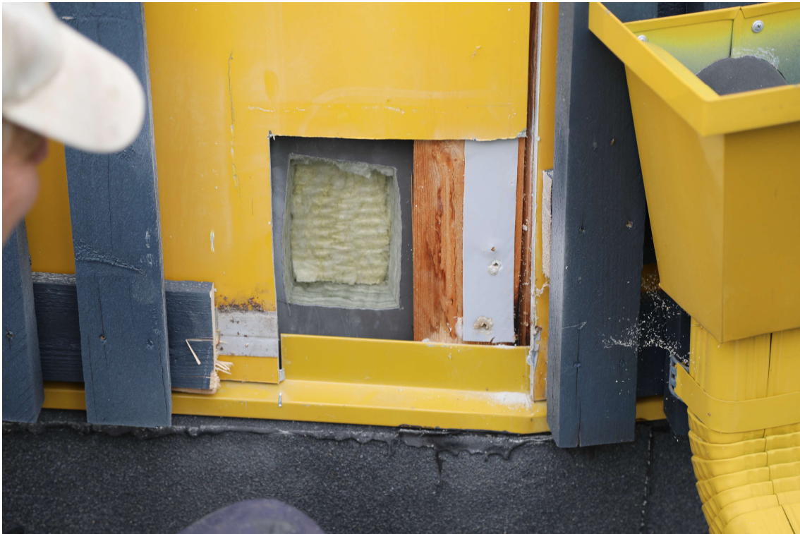
Foto 7. Seintarindi MW soojusisolatsioonikihi peale on paigaldatud ca 30 mm paksune MW tuuletõkkepladikiht.
